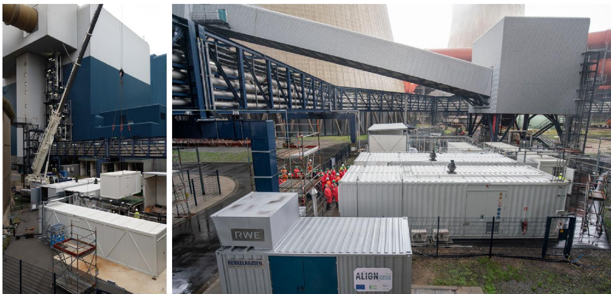
Abbildung 5: Die Errichtung der ALIGN-CCUS-Anlage erfolgte im Oktober 2019. Bild links: Installation des Kompressor-Moduls für die DME-Synthese und CO 2 -Wäsche-Pilotanlage am Gebäude der Rauchgasentschwefelungsanlage von Block K in Niederaußem. Rechtes Bild: vorne links – Stromerzeugermodul; vorne rechts – zwei Container mit der alkalischen Elektrolyse; hinten rechts – drei Container mit der DME-Syntheseeinheit; hinten links: offene Einhausung für die Lagerung des produzierten Roh-DME.
